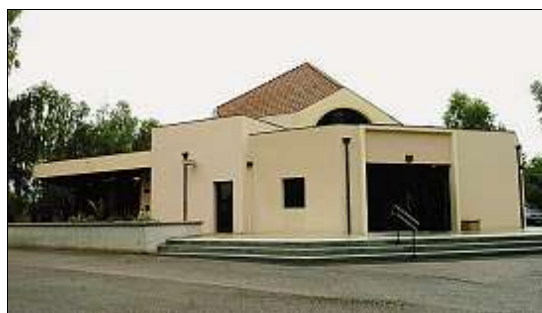
CRÉMATORIUM. Désormais, après les travaux, la salle peut accueillir une centaine de personnes supplémentaires en plus des places assises. PHOTO JEAN-LUC SIMON
